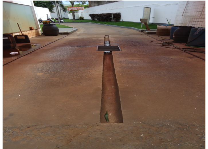
Imagem 07: Área do lavador, composta por piso em concreto impermeável e canaletas de contenção e queda dos resíduos com destinação para a CSAO. Autor: Esfera Ambiental 2012.
