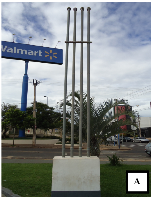
Imagem 09: Em (A) respiros de contenção de gases dos tanques instalados no empreendimento e em (B) monitor intersticial dos tanques. Autor: Esfera Ambiental 2013 .
