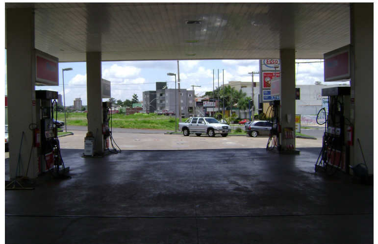
Imagem 02: Área da pista de abastecimento do empreendimento composta por concreto impermeável usinado circulado pelas canaletas coletoras de resíduos líquidos. Autor: Esfera Ambiental 2013.
