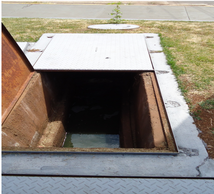
Imagem 06: Caixas separadora de água e óleo (CSAO) instaladas no empreendimento. Autor: Esfera Ambiental 2012.
