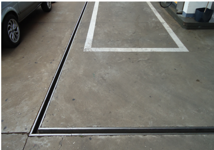
Imagem 02: Área da pista de abastecimento do empreendimento composta por concreto impermeável usinado circulado pelas canaletas coletoras de resíduos líquidos. Autor: Esfera Ambiental 2013.
