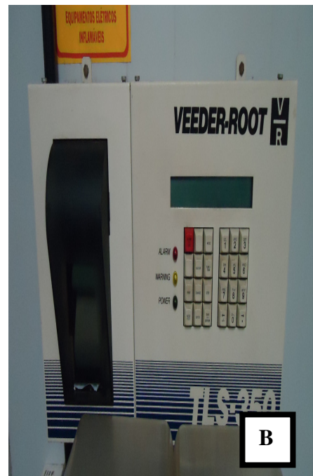
Imagem 09: Em (A) respiros de contenção de gases dos tanques instalados no empreendimento e em (B) monitor intersticial dos tanques. Autor: Esfera Ambiental 2013 .
