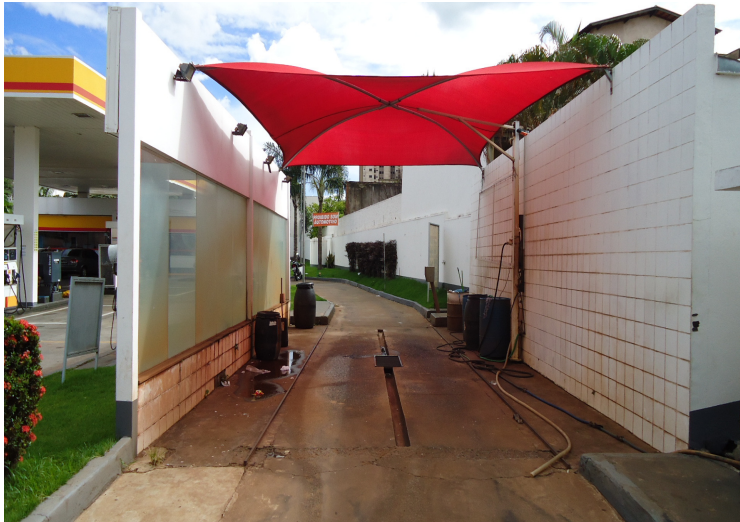
Imagem 07: Área do lavador, composta por piso em concreto impermeável e canaletas de contenção e queda dos resíduos com destinação para a CSAO. Autor: Esfera Ambiental 2012.
