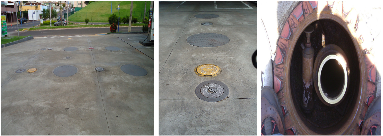
Imagem 03: Área de descarga do combustível no empreendimento constando com a área da descarga e entrada dos tanques por suas câmaras de calçada, em boca de visita dos tanques subterrâneos. Autor: Esfera Ambiental 2013.
