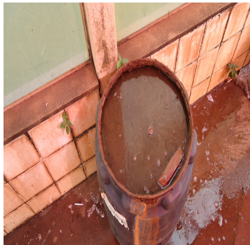
Imagem 08: Resíduos gerados no empreendimento de lama da caixa (SAO) devidamente acondicionados, aguardando destinação para empresa coletora responsável. Autor: Esfera Ambiental 2013.
