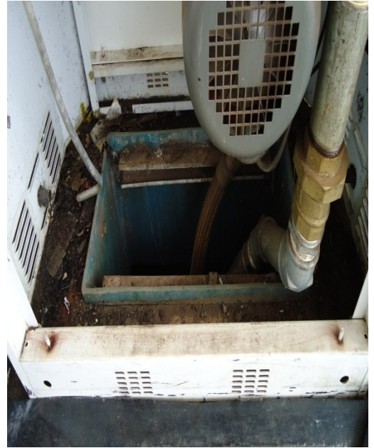
Imagem 05: Bomba de abastecimento eletrônica instalada no empreendimento com seu reservatório de contenção (SUMP) instalado. Autor: Esfera Ambiental 2013 .
