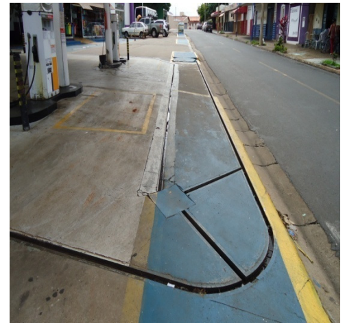
Imagem 02: Área da pista de abastecimento do empreendimento composta por concreto impermeável usinado circulado pelas canaletas coletoras de resíduos líquidos. Autor: Esfera Ambiental 2013.
