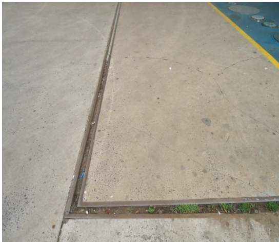
Imagem 02: Área da pista de abastecimento do empreendimento composta por concreto impermeável usinado circulado pelas canaletas coletoras de resíduos líquidos. Autor: Esfera Ambiental 2013.
