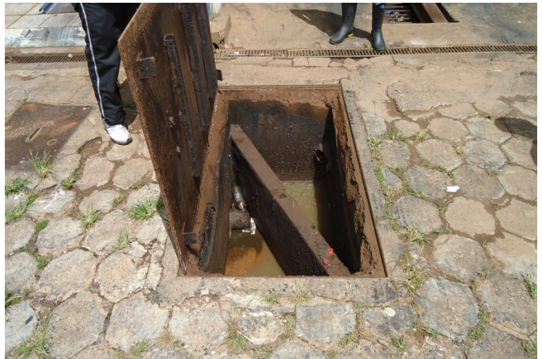
Imagem 06: Caixas separadoras de água e óleo (CSAO) da área de abastecimento e lavador instaladas no empreendimento. Autor: Esfera Ambiental 2013 .
