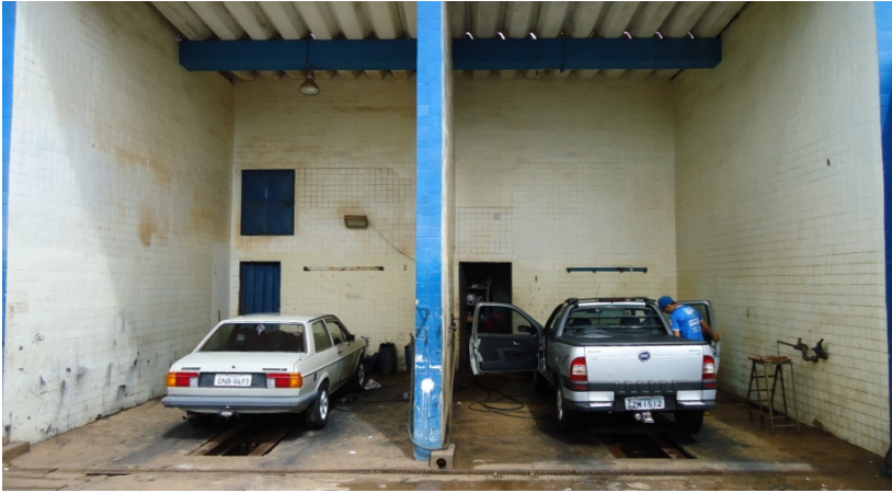
Imagem 07: Área do lavador, composta por piso em concreto e canaletas de contenção. Autor: Esfera Ambiental 2013.
