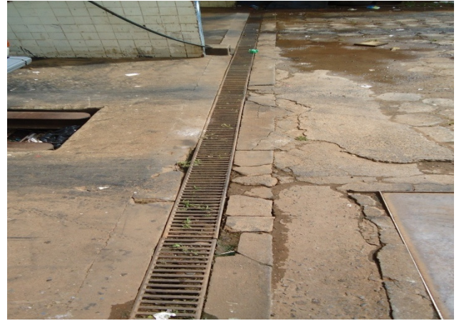
Imagem 07: Área do lavador, composta por piso em concreto e canaletas de contenção. Autor: Esfera Ambiental 2013.
