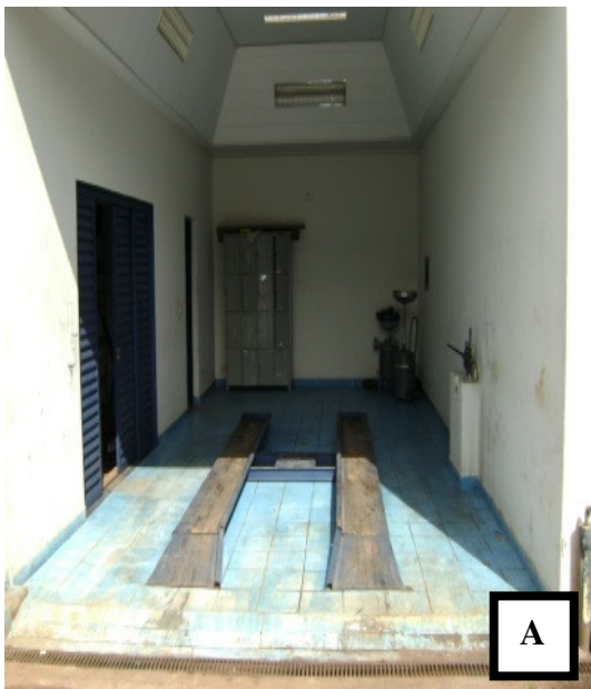
Imagem 04: Em (A) área de troca de óleo do empreendimento constituída em piso em concreto usinado impermeável, em (B) depósito para armazenamento dos óleos lubrificantes e em (C) embalagens de óleo usado em bacia de contenção para retirada de excesso de óleo. Autor: Esfere Ambiental 2013 .
