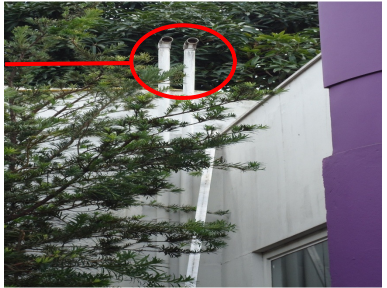
Imagem 09: Respiros de contenção de gases dos tanques instalados no empreendimento. Autor: Esfera Ambiental 2013 .
