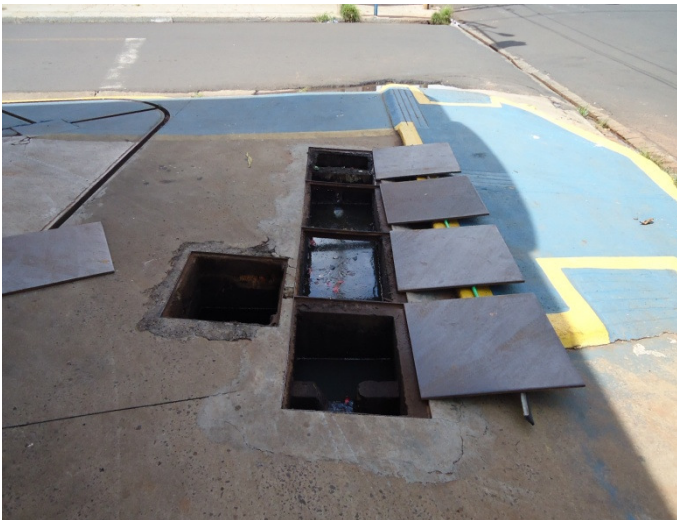
Imagem 06: Caixas separadoras de água e óleo (CSAO) da área de abastecimento e lavador instaladas no empreendimento. Autor: Esfera Ambiental 2013 .
