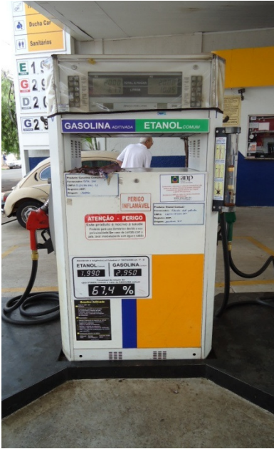
Imagem 05: Bomba de abastecimento eletrônica instalada no empreendimento com seu reservatório de contenção (SUMP) instalado. Autor: Esfera Ambiental 2013 .
