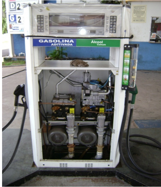
Imagem 05: Bomba de abastecimento eletrônica instalada no empreendimento com seu reservatório de contenção (SUMP) instalado. Autor: Esfera Ambiental 2013 .
