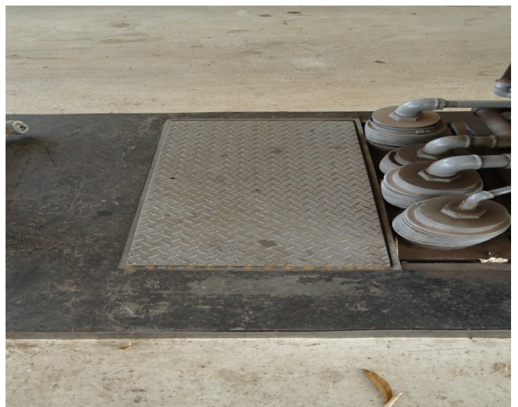
Imagem 10: Filtro de óleo diesel instalado no empreendimento com sua câmara de calçada que dá acesso ao reservatório de contenção (SUMP) das linhas do equipamento. Autor: Esfera Ambiental 2013 .
