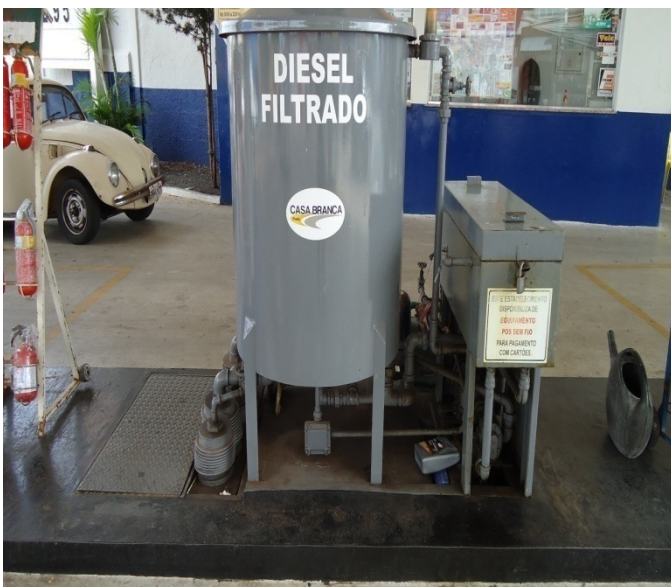
Imagem 10: Filtro de óleo diesel instalado no empreendimento com sua câmara de calçada que dá acesso ao reservatório de contenção (SUMP) das linhas do equipamento. Autor: Esfera Ambiental 2013 .
