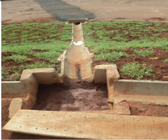
Foto 3 – Sistema de drenagem de águas pluviais. Fonte – SEMAT
