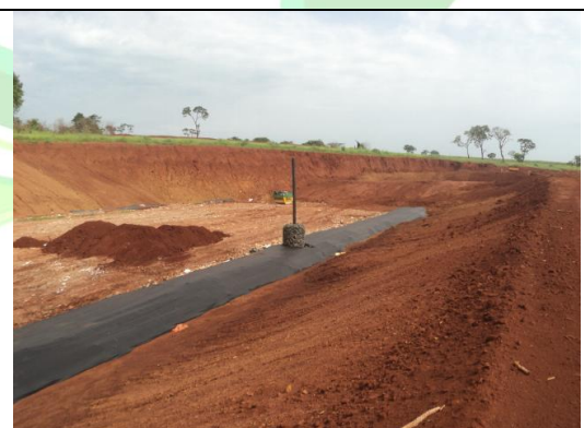
Foto 2 – Drenagem dos gases
