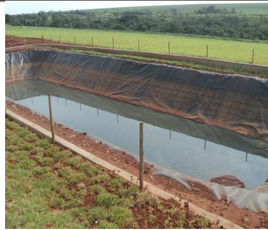
Foto 4 – Lagoa de Chorume com fundo impermeabilizado Fonte – SEMAT
