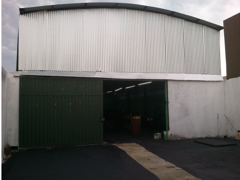
Foto 5 - Galpão onde estão Enclausurados os Equipamentos
