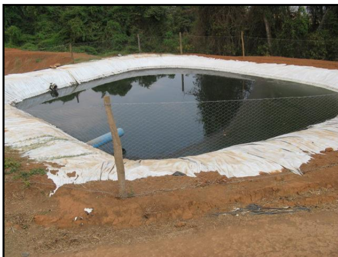
Figura 4: Tanque de Armazenamento
