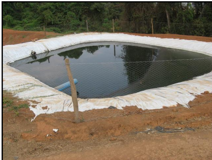
Figura 4: Tanque de Armazenamento
