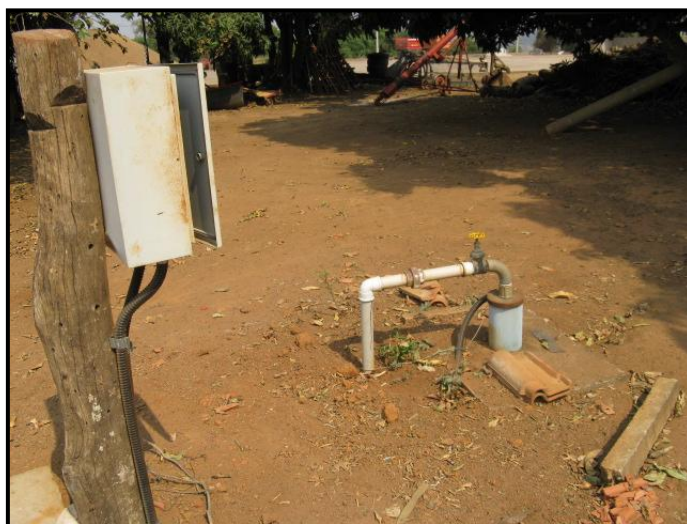
Figura : Cisterna Tubular.
