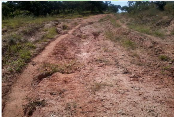
Foto 9 – Erosão Fonte – SEMAT, Abril - 2013.
