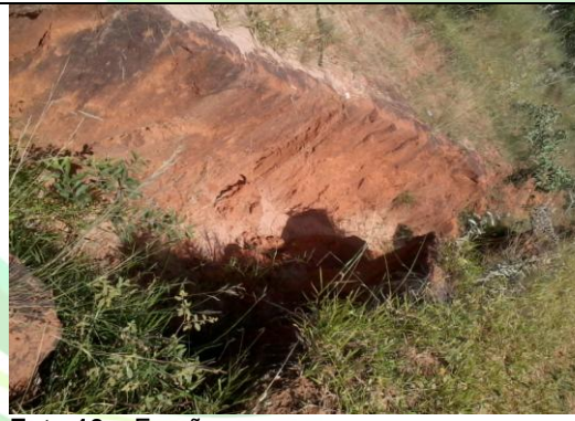
Foto 10 – Erosão Fonte – SEMAT, Abril - 2013.
