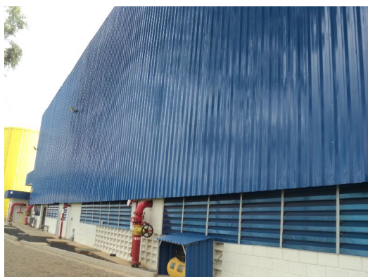
Foto 1 – Vista do Centro de distribuição.
