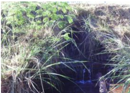
Figura 27: Pequeno tributário tubulado sob a avenida.
