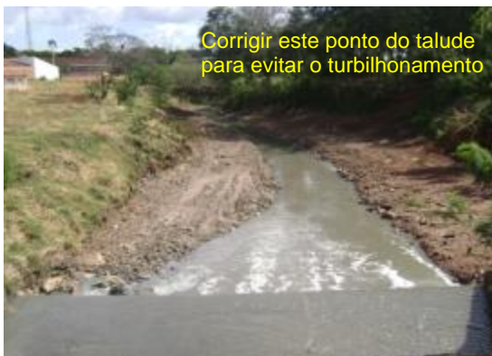
Figura 17: Correção do talude (quebra de bico).
