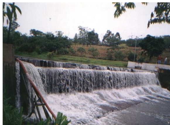
Figura 3.14: Represa da captação em funcionamento normal
