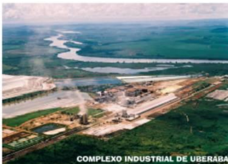
Figura 3.12: Distrito Industrial III, Uberaba-MG
